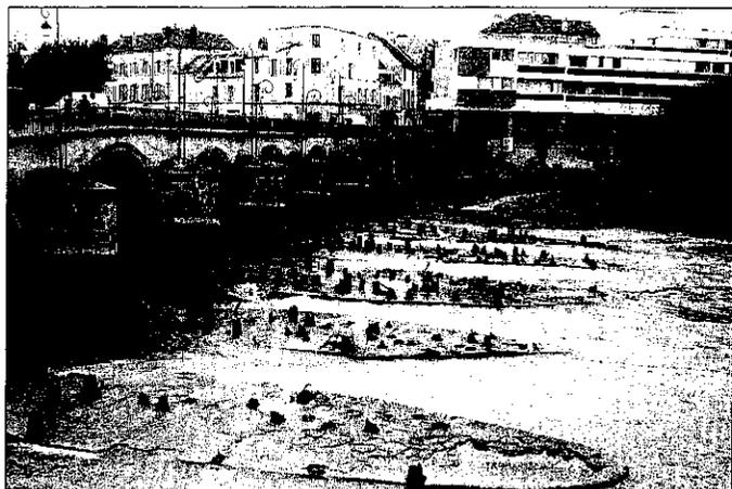
**Fig. 2 - Fondations des moulins du pont raide de Meaux (Cliché M. Paulet - Service Navigation de la Seine).**
